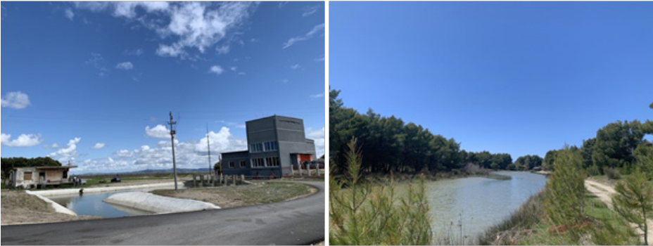
Figura 4. Majtas, pamje e Stacionit të Pompimit të Akërnisë, dhe e kanalit që e lidh atë me detin ( djathtas ).
